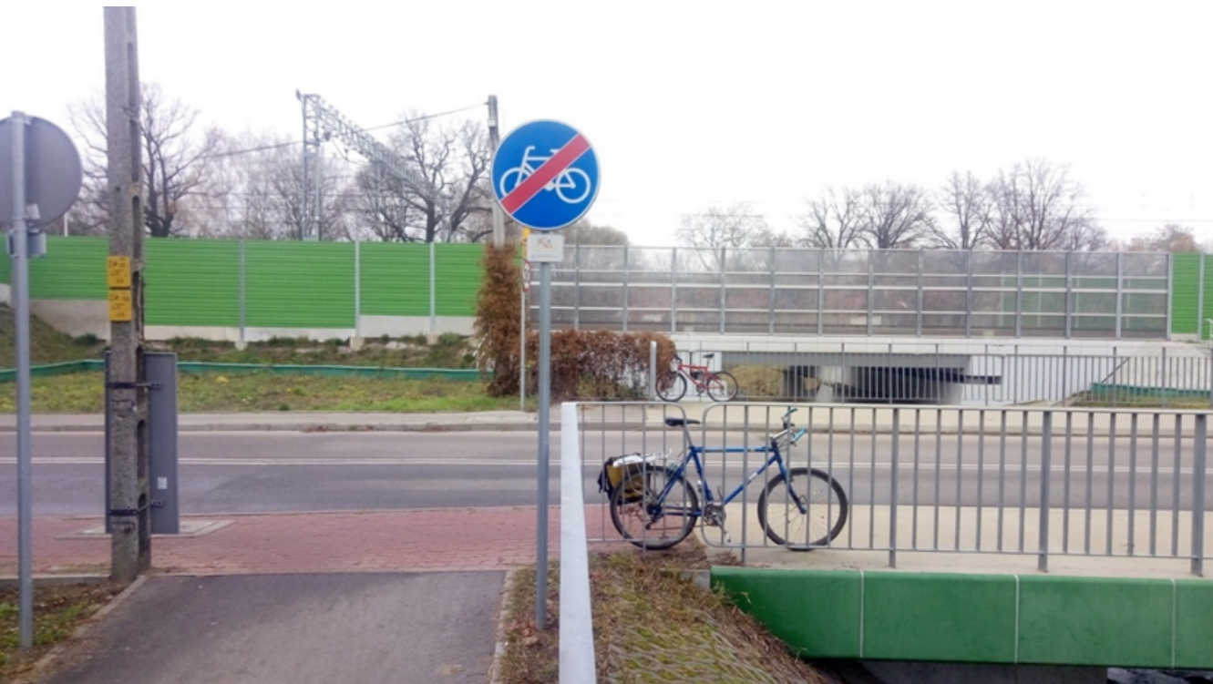
Rysunek 5. Nieuwzględnienie kluczowych elementów infrastruktury rowerowej w projektach „dużych” inwestycji powoduje, że trasy realizowane przez samorządy urywają się ślepo np. na linii kolejowej lub na węźle drogi ekspresowej.
